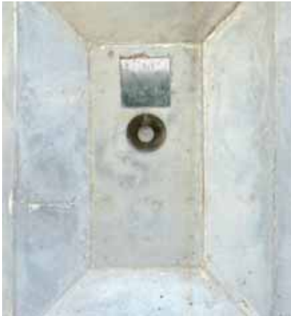
Ansicht des Ankers nach Entfernen des Aussparungskörpers
