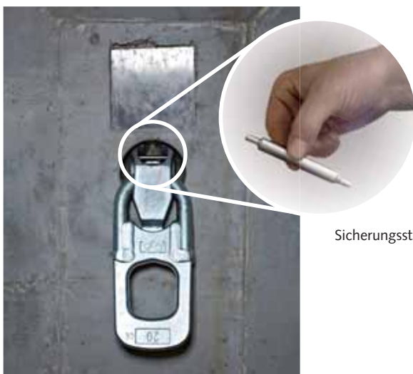
Eingeklinkte Kupplung vor dem Anbringen der Sicherungskette
